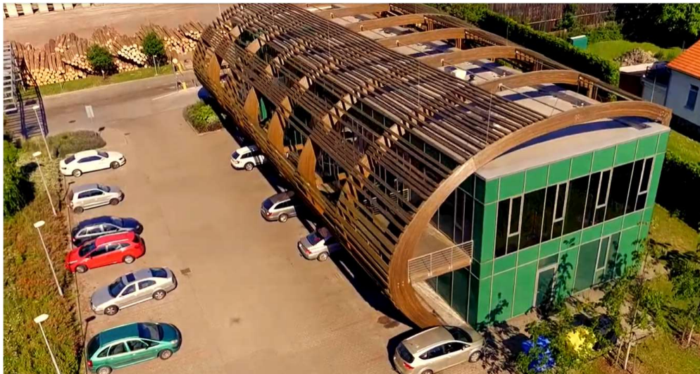
Obrázok 19: Administratívna budova areálu LESS & TIMBER v Čáslavi – image drevospracujúcej firmy
